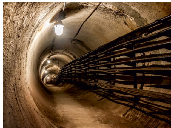
Решения для прокладки подземных коммуникаций
